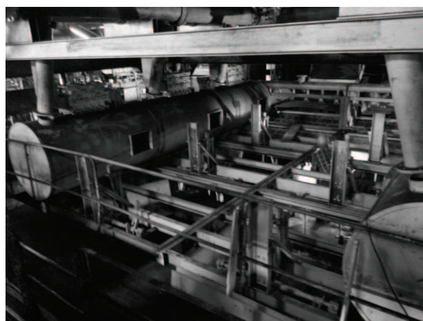
Rys. 2. Osadzarka mialowa OM30 KWK Sośnica w trakcie montażu
