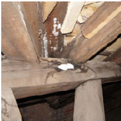
Ryc. 5. Grzyby domowe w więźbie dachowej: a) widok śladów grzybnii w węźle elementów konstrukcyjnych, b) widok uszkodzonego przez grzyb fragmentu oparcia krokwi
