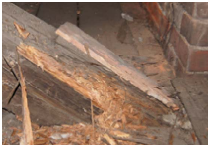
Ryc. 5. Grzyby domowe w więźbie dachowej: a) widok śladów grzybnii w węźle elementów konstrukcyjnych, b) widok uszkodzonego przez grzyb fragmentu oparcia krokwi
