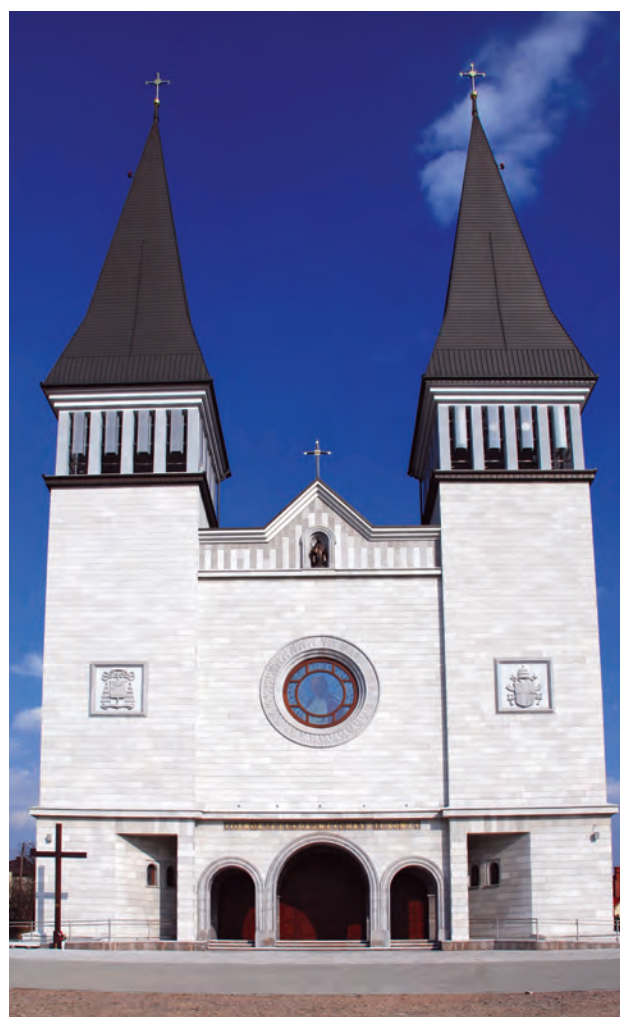
Ryc. 12. Kościół pw. św. Jana Pawła II w Krzeszowicach. Ryc. 2, 5, 11, 12 fot. P. Kuć
