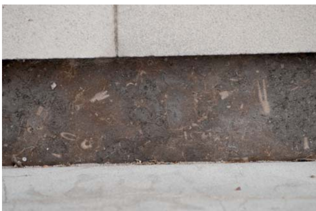
Ryc. 7. Fragmenty krynowidów w wapieniu – cokóły schodów Fig. 7. Crushed crinoids in a limestone – stair plinths
