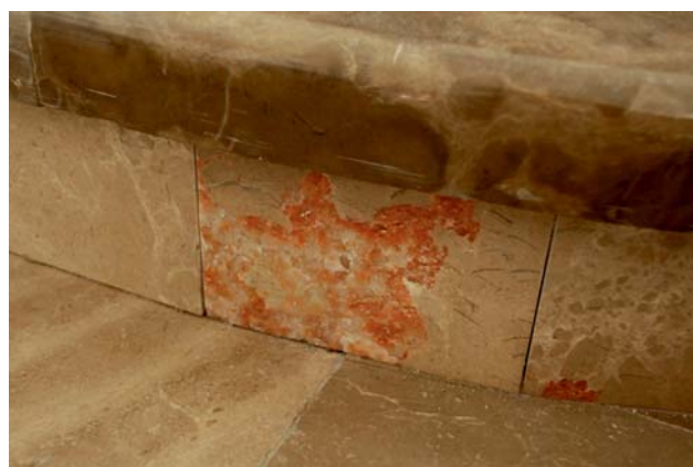
Ryc. 6. Czerwone kalcyty, tzw. różanka paczółtowicka, w wapieniu – cokoły schodów Fig. 6. Red calcite, “Paczółtowicka rose-stone” in a limestone – stair plinths
