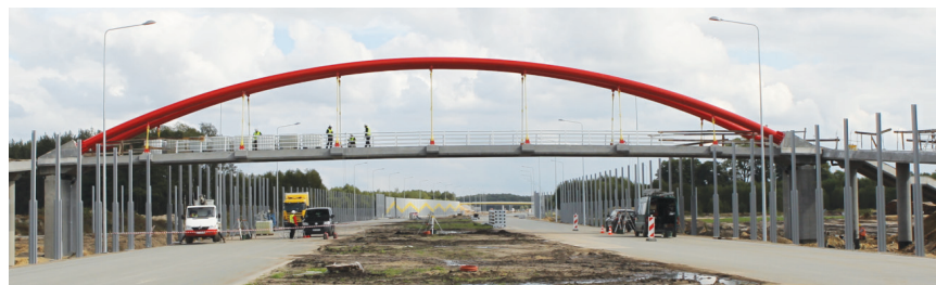
Rys. 2. Widok z boku kładki nad drogą S8
