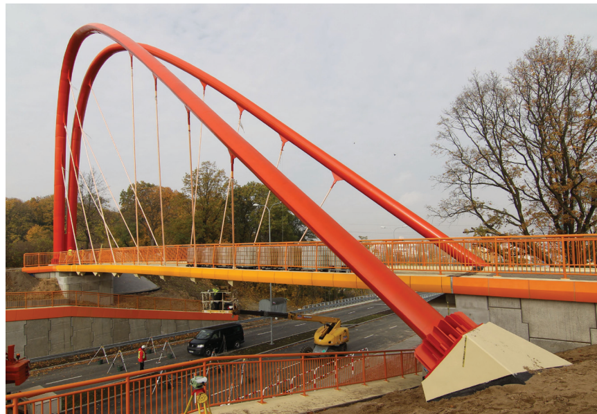
Rys. 3. Widok z boku kładki nad Trasą Uniwersytecką w Bydgoszczy
