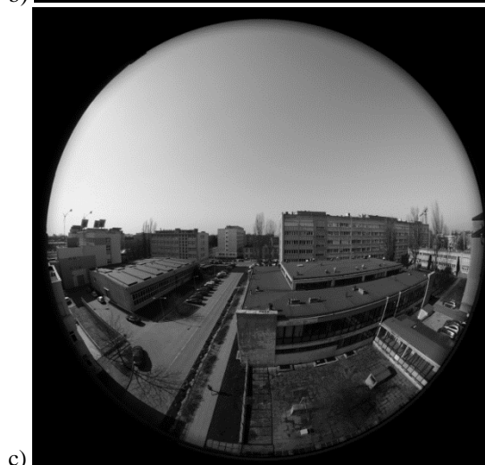
Rys. 6. Zdjęcia z elewacji zachodniej przekształcone na kanały a) czerwony, b) zielony, c) niebieski. Fig. 6. Photos from the western elevation converted to a) red b) green c) blue channel.
