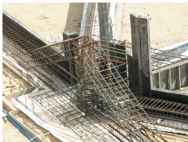
Rys. 9. Widok na szczegół zbrojenia ściągów i stopy fundamentowej (Archiwalne ...) Fig. 9. View of the detail of tie rods and foundation heel reinforcement (Archiwalne ...)
