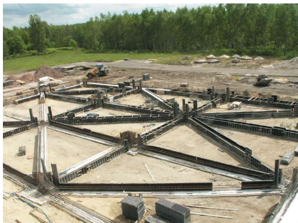
Rys. 8. Widok na zbrojenie ściągów i stóp fundamentowych oraz szalunki do betonowania (Archiwalne ...) Fig. 8. View of the reinforcement of tie rods and foundation heels as well as concrete formwork (Archiwalne ...)
