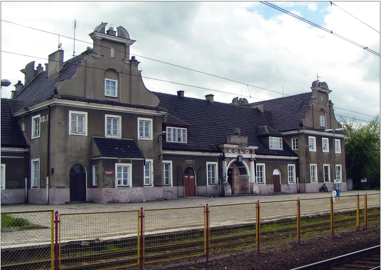
5. Dworzec kolejowy w Kole przed remontem, ul. Kolejowa 1. Fot. K. Torzecki, 2005 5. Kolo Railway Station before the renovation, 1 Kolejowa St. Photo by K. Torzecki, 2005
