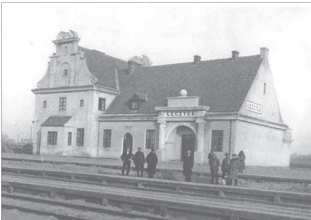
3. Dworzec kolejowy w Łęczycy w trakcie budowy, ok. 1925 r. Fot. A. Konecki 3. Łęczycza Railway Station under construction, c. 1925. Photo by A. Konecki
