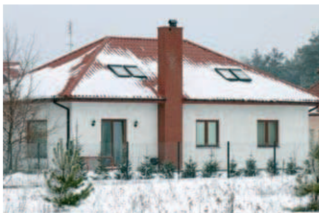
Rys. 12. Komin poza obrysem domu mieszkalnego. Fatalny dostęp dla służb kominarskich, schłodzenie trzonu przez zimny wiatr utrudniające prawidłową pracę komina, narażenie konstrukcji murów komina na zawilgocenia (objawiające się tzw. wykwitami), brak stężenia komina z konstrukcją budynku – zagrożenie powstawania zarysowań w ścianach komina powstających pod naporem silnych wiatrów [12]
