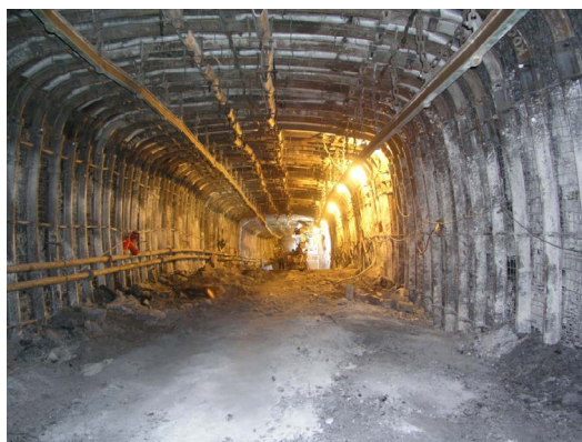
Rys. 7. Przecinka rozruchowa w obudowie LPrP w LW Bogdanka (fot. A. Ruchel)
