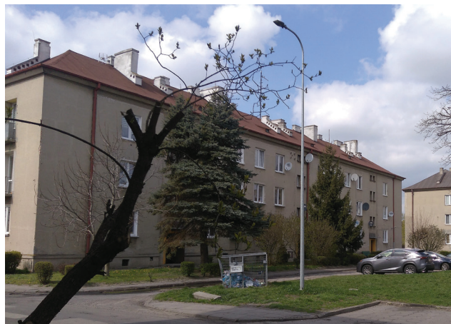
Fot. 4c. Bloki mieszkalne z lat 50. XX w.; źródło: Renata Przewłocka-Sionek, obecnie
