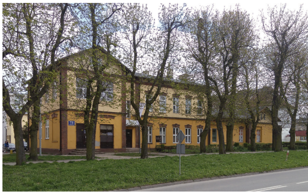
Fot. 2. Dawna szkoła, obecnie budynek mieszkalny; źródło: Anna Larecka, 2022
