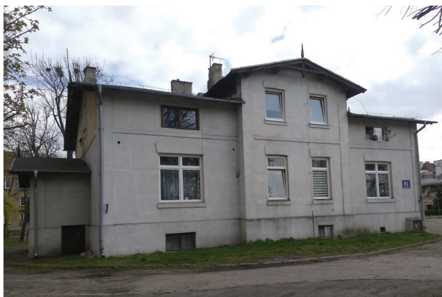
Fot. 3. Fabryczny szpital, obecnie budynek mieszkalny; źródło: Anna Larecka, obecnie
