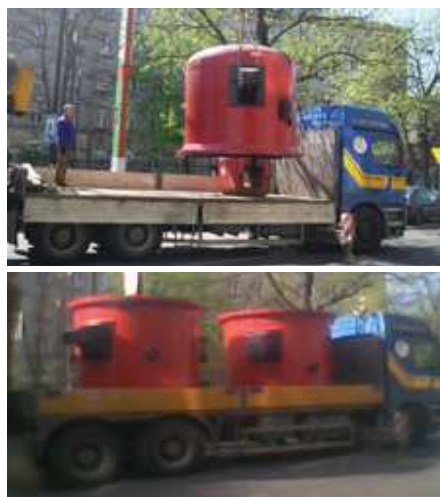
Fot. 10-13 Demontaż akceleratora „Lech” i transport zbiornika ciśnieniowego do NCBJ w Świerku
