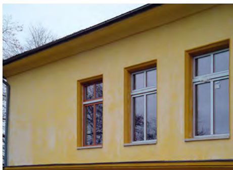
Fot. 1–3. Przykłady występowania nalotów solnych na powierzchni mineralnego tynku cienkowarstwowego (fot. Bartosz Polaczyk)
