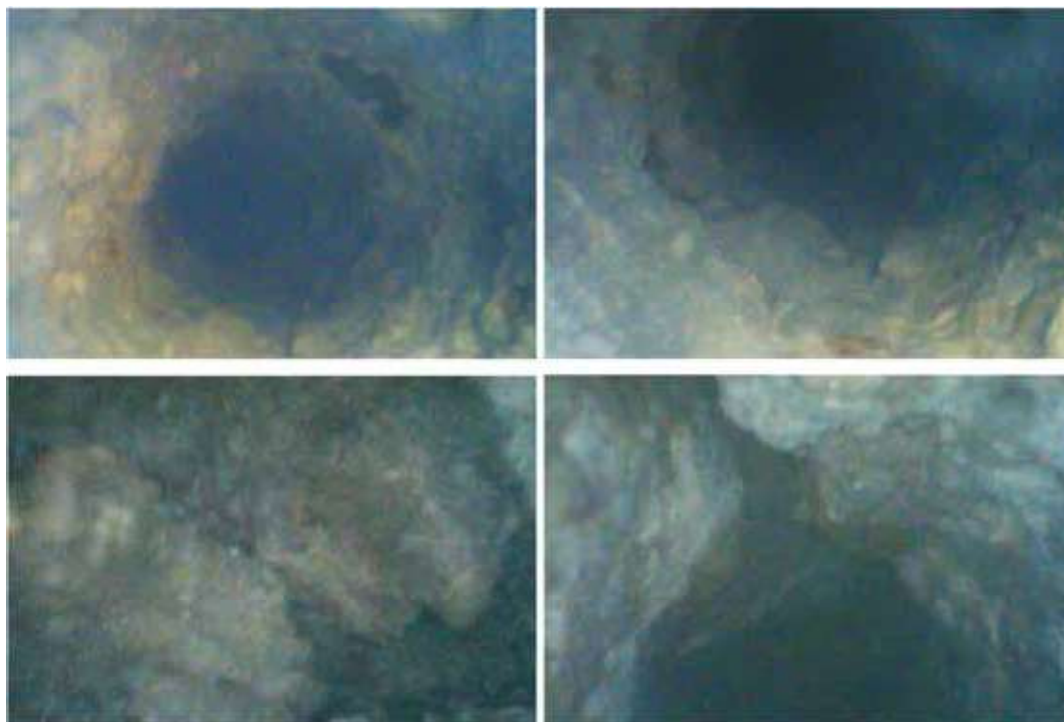
Rys. 8. Widoki wnętrza otworu Fig. 8. View from the inside of the holes
