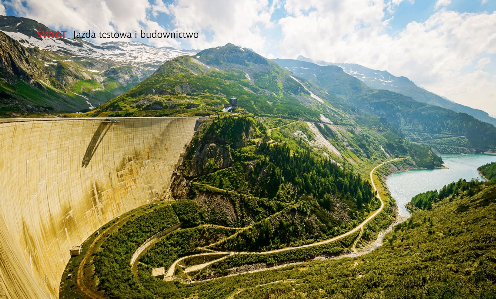
W górnej części doliny rzeki Kapruner znajduje się elektrownia wodna i dwie wysokie zapory. Projekt powstał w 1928 r. i przewidywał, że zbiorniki wodne rozciągające się na przestrzeni ponad 1000 km przez przełęcze alpejskie będą mogły produkować energię w dowolnym czasie i ilości, fot. dannywildey, fotolia.com
