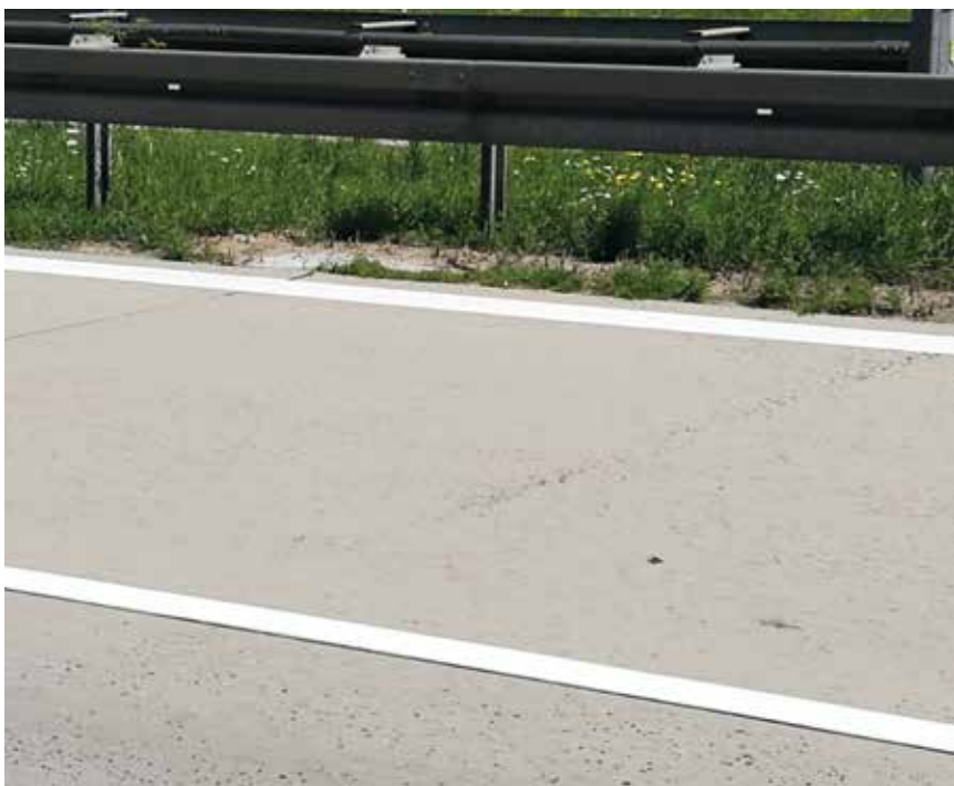
Rys. 9. Wykruszenia podłużnych i poprzecznych krawędzi płyt oraz lokalne wytarcie mleczka cementowego (fotografie autora 2018 r.)
