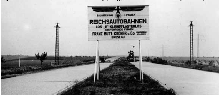
Rys. 2. Autostrada RAB 9 w latach budowy (fotografia z zasobów: www.fotopolska.eu )
