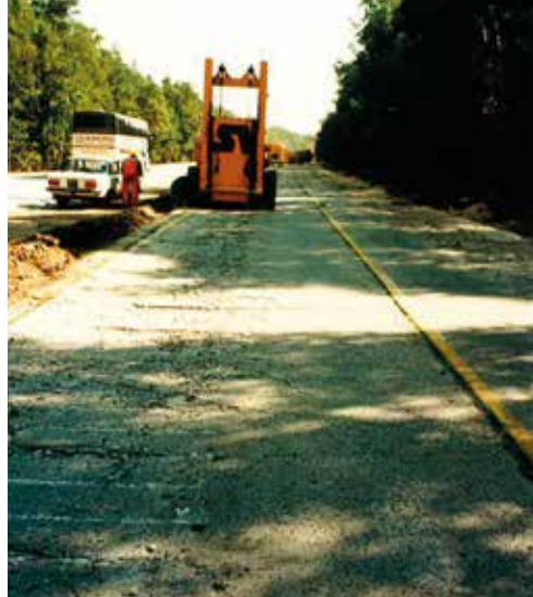
Rys. 6. Fotografie z okresu odprężania, rozbiórki i usuwania starych płyt betonowych (fotografie z zasobów archiwum WTLD we Wrocławiu)
