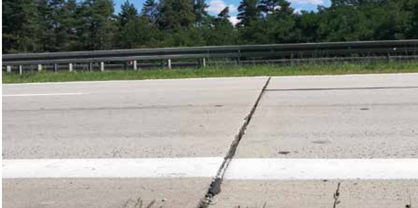
Rys. 8. Wybrzuszenie nawierzchni asfaltowej na granicy z betonową oraz klawisz powstały na sąsiadujących płytach betonowych (fotografie autora 2018 r.)
