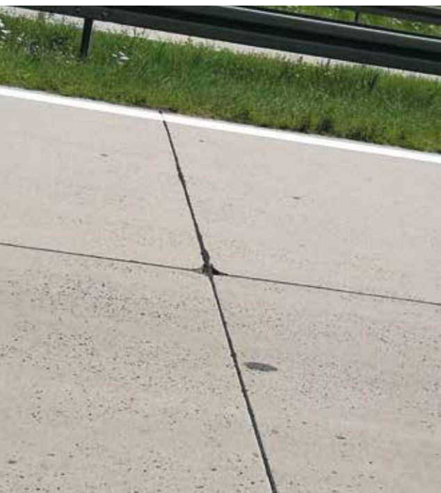
Rys. 8. Wybrzuszenie nawierzchni asfaltowej na granicy z betonową oraz klawisz powstały na sąsiadujących płytach betonowych (fotografie autora 2018 r.)
