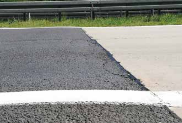
Rys. 8. Wybrzuszenie nawierzchni asfaltowej na granicy z betonową oraz klawisz powstały na sąsiadujących płytach betonowych (fotografie autora 2018 r.)
