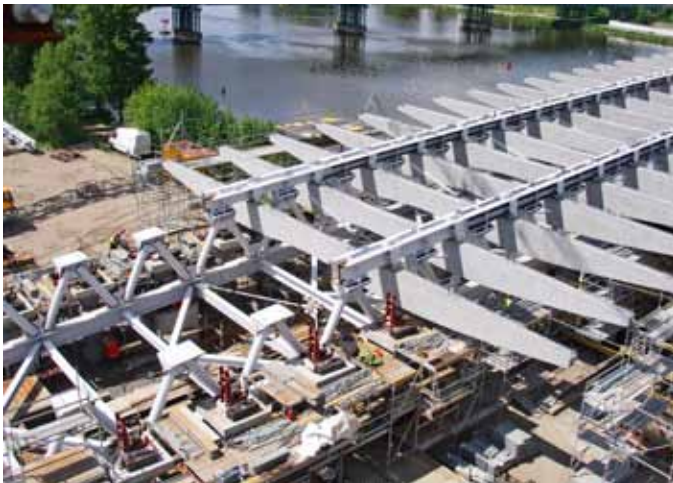
Ryc. 4. Stanowisko montażowe i część wysuniętego rusztu
