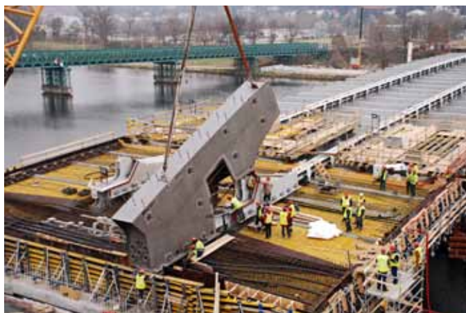
Ryc. 7. Osadzanie podstawy łuku
