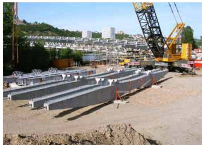
Ryc. 12. Poprzecznice prefabrykowane na składzie
