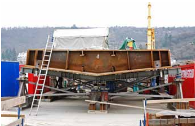
Ryc. 15. Przekrój łuku w części środkowej
