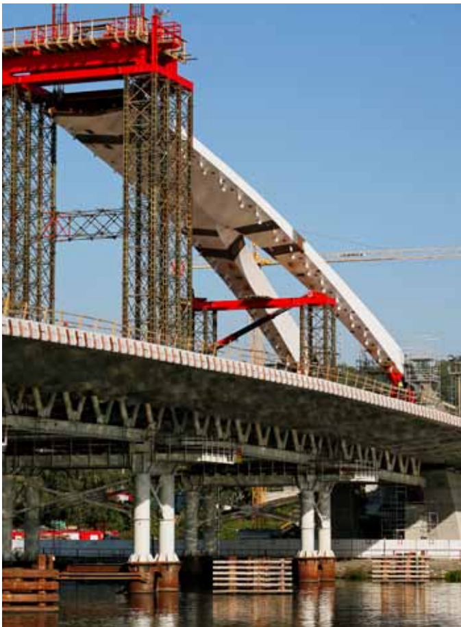
Ryc. 9. Wznoszenie skrajnej części łuku po stronie Troi
