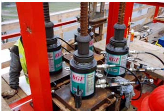
Ryc. 11. Walce hydrauliczne unoszące część łuku na prętach wieszakowych
