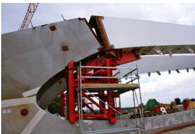
Ryc. 8b. Skrajna część łuku osadzona na sworzniu
