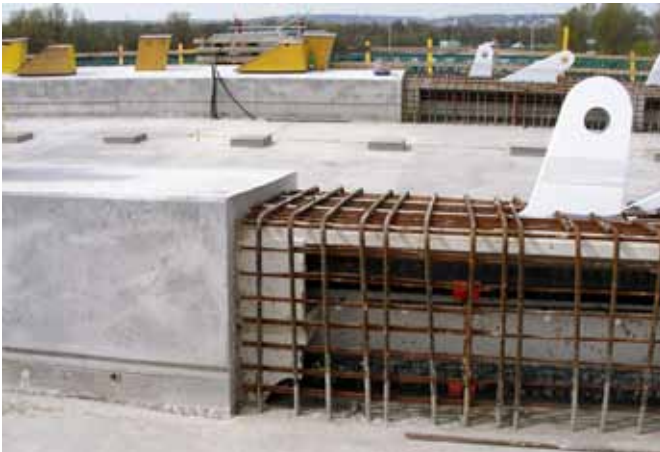
Ryc. 14. Ciężno łuku przed i po betonowaniu
