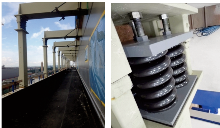
Rys. 2. Typowe rozwiązanie tłumików drgań na przykładzie lądowiska szpitala w Sztokholmie [6]
