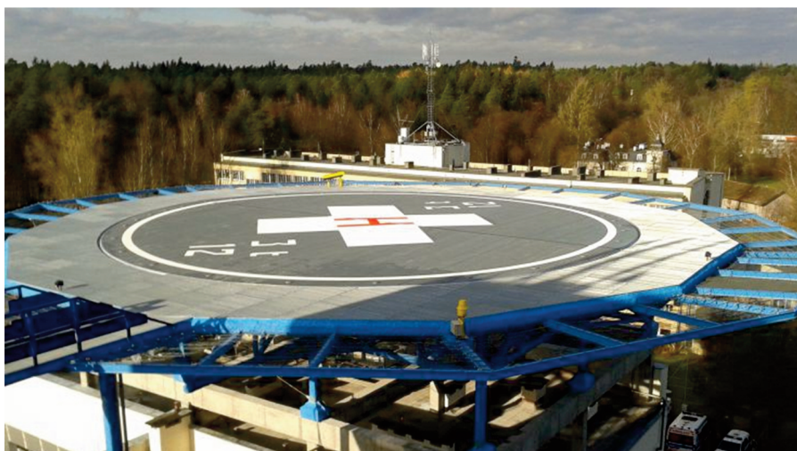
Rys. 1. Lądowisko szpitala MSWiA w Olsztynie [fot. A.Koper]
