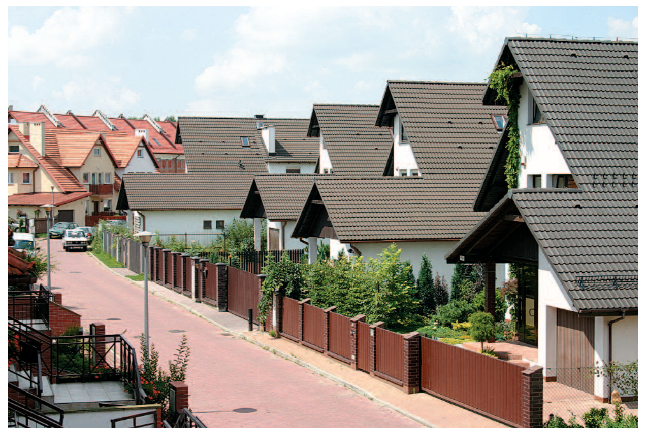
▼ Osiedle CPN w Krakowie, widok ogólny. CPN Estate in Cracow, general view. (arch. A. Kadluczka, wsp./coop. J. Czubiński, K. Styrna-Bartkoviczowa).
