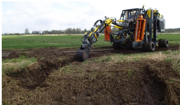
Fig. 15. Digging up the escarpment by spoon Rys. 15. Rozkopywanie skarpy łyżką podsiębierną
