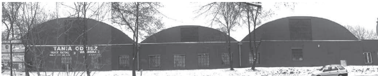
Rys. 3. Lublin, Hangar żelbetowy fabryki samolotów z 1930 r., stan obecny
