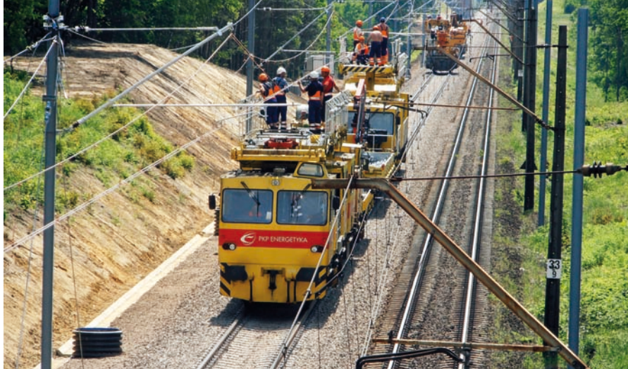
Montaż nowej sieci trakcyjnej na modernizowanej linii kolejowej, fot. PKP PLK SA
