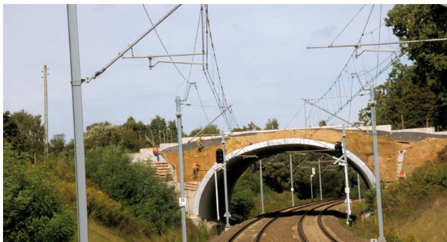
Ekodukt – przejście dla dużych zwierząt nad modernizowaną linią kolejową, fot. PKP PLK SA
