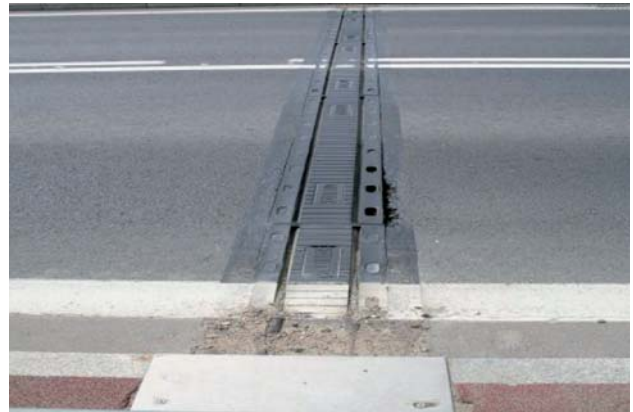
Fot. 16. Niewystarczające utrzymanie: a) zaawansowana korozja blachy ostonowej, b) lokalny ubytek masy przejściowej
