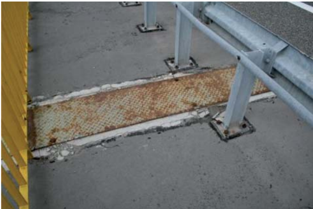
Fot. 16. Niewystarczające utrzymanie: a) zaawansowana korozja blachy ostonowej, b) lokalny ubytek masy przejściowej
