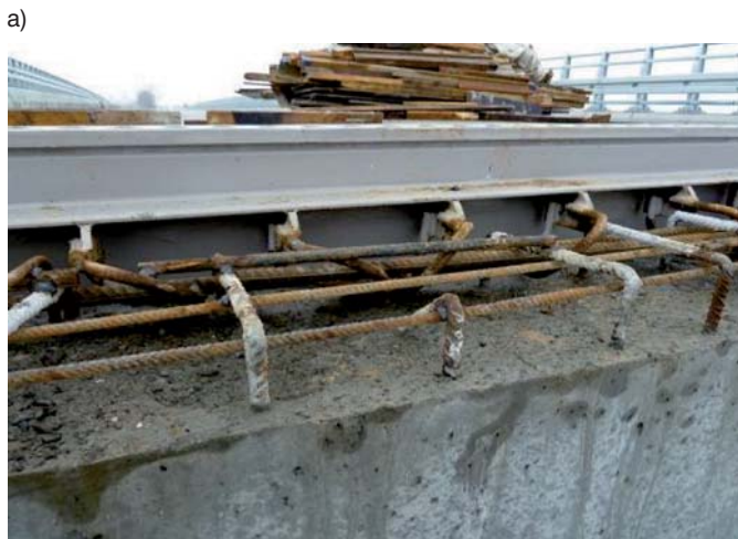
Fot. 7. Wadliwy montaż prętów zbrojeniowych
