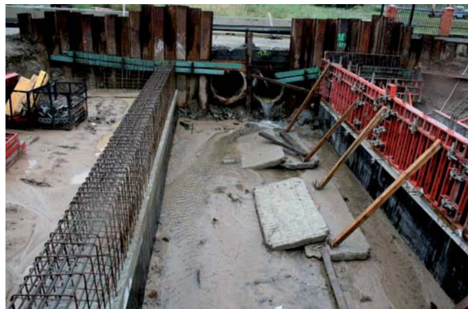
Rys. 4. Przebudowa dwuotworowego przepustu rurowego na mały most z belek typu DS 6
