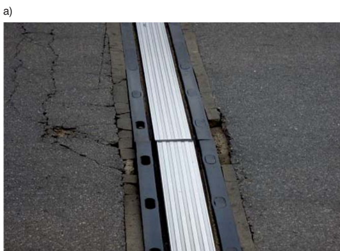
Fot. 9. Luźne śruby kotwiące urządzenia dylatacyjne: a) blokowe, b) modułowe
