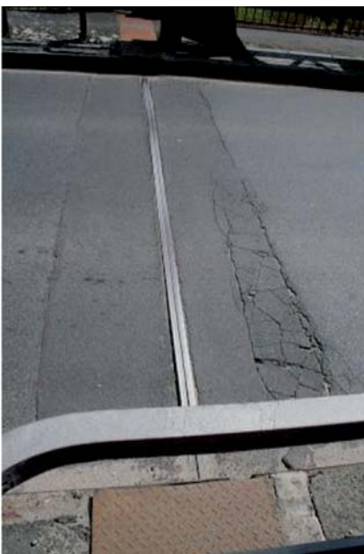
Fot. 17. Uszkodzenie nie kwalifikujące się do naprawy w ramach bieżącego utrzymania: a) brak szczeliny dylatacyjnej w urządzeniu modułowym, b) systematyczne wykruszanie się zaprawy przejściowej w urządzeniu blokowym
