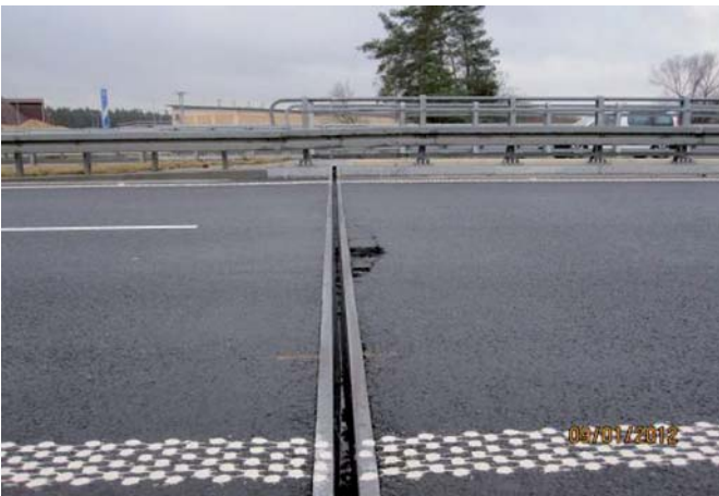
Fot. 11. Niewystarczające zagęszczenie bitumicznej nawierzchni jezdni wzdłuż profili stalowych
