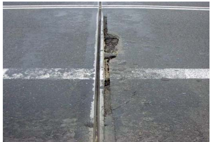
Fot. 11. Niewystarczające zagęszczenie bitumicznej nawierzchni jezdni wzdłuż profili stalowych
