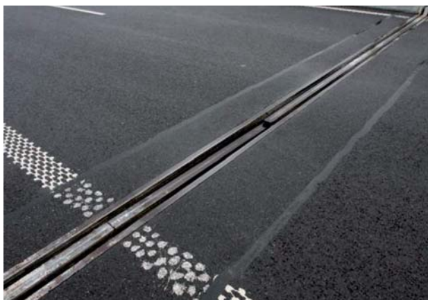
Fot. 14. Awarie urządzeń dylatacyjnych: a) pęknięcie profilu środkowego, b) oderwane nakładki tłumiące hałas
