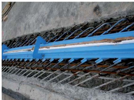
Fot. 15. Mankamenty urządzeń dylatacyjnych: a) zaawansowana korozja elementów mechanizmu nożycowego, b) za mała średnica prętów pętli kotwiących oraz zbyt mała liczba poprzecznych prętów zbrojeniowych
