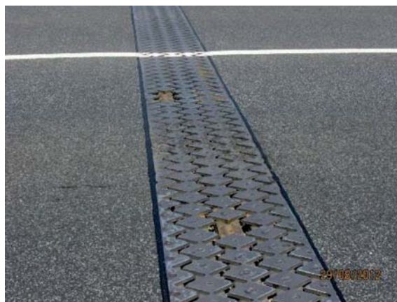
Fot. 14. Awarie urządzeń dylatacyjnych: a) pęknięcie profilu środkowego, b) oderwane nakładki tłumiące hałas
