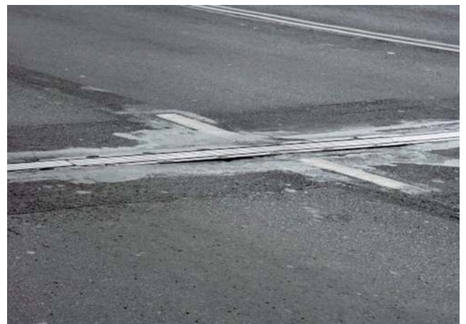
Fot. 12. Progi w nawierzchni jezdni w strefach dylatacyjnych: a) zbyt duża grubość warstwy ścieralnej, b) zbyt mała grubość warstwy ścieralnej
