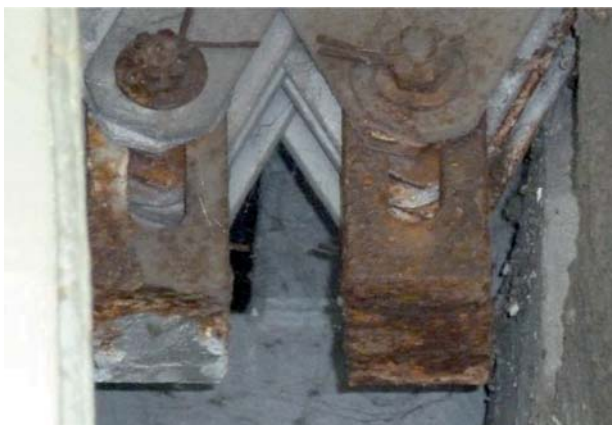
Fot. 15. Mankamenty urządzeń dylatacyjnych: a) zaawansowana korozja elementów mechanizmu nożycowego, b) za mała średnica prętów pętli kotwiących oraz zbyt mała liczba poprzecznych prętów zbrojeniowych
