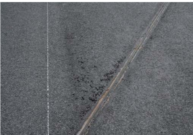
Fot. 12. Progi w nawierzchni jezdni w strefach dylatacyjnych: a) zbyt duża grubość warstwy ścieralnej, b) zbyt mała grubość warstwy ścieralnej
