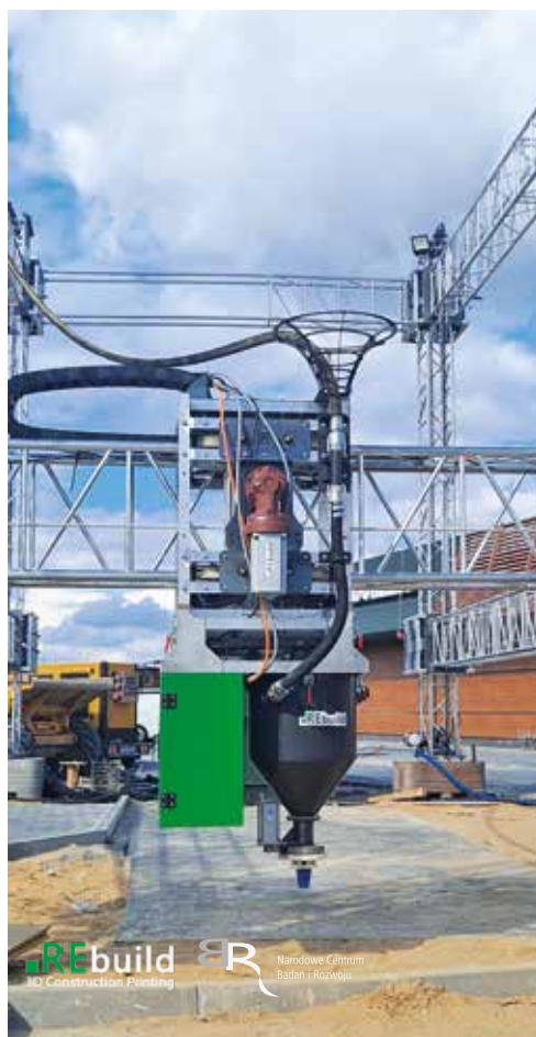
Fot. 2. Drukarka produkcji firmy REbuild na placu budowy
