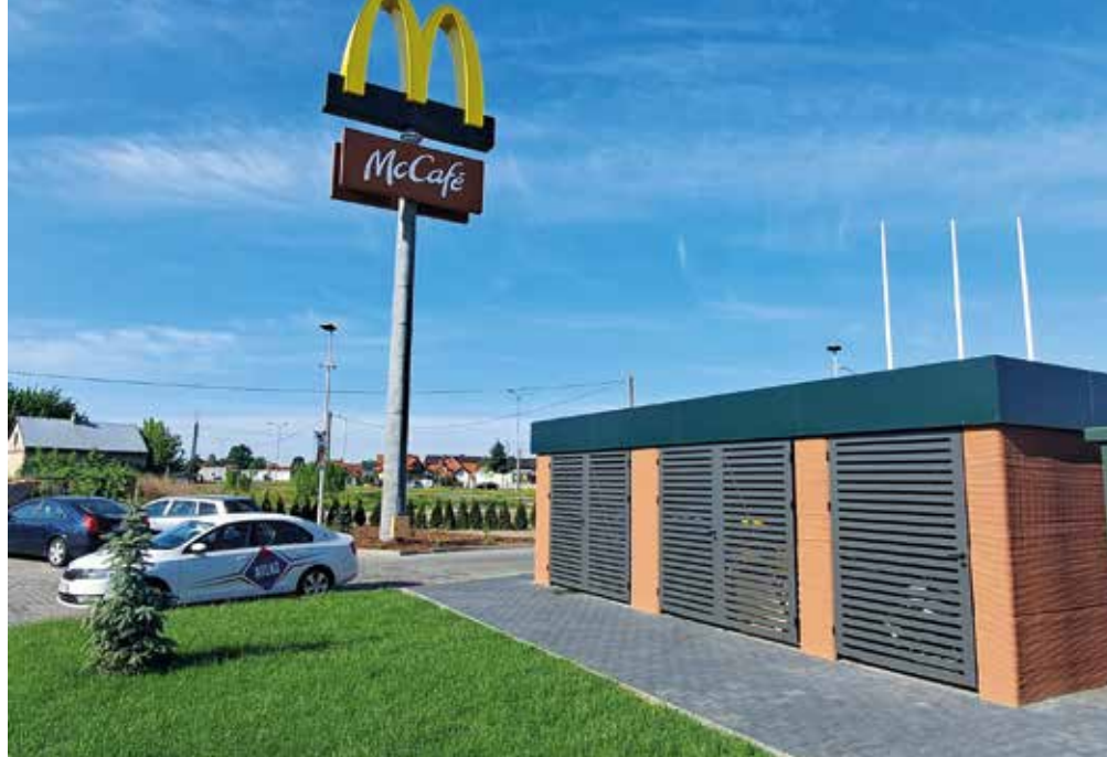
Fot. 1. Wydrukowany budynek techniczny przy restauracji McDonald's w Wyszkanie
