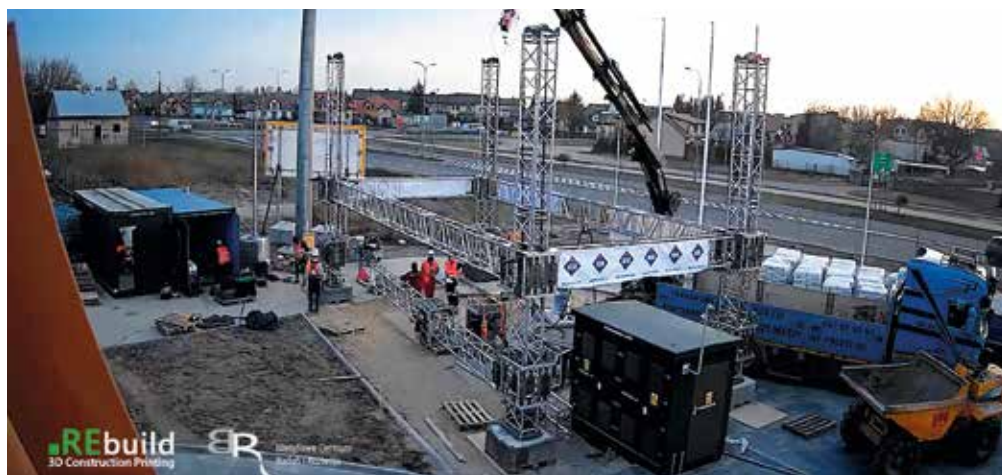
Fot. 3. Drukarka REbuild podczas pracy w Wyszkowie
