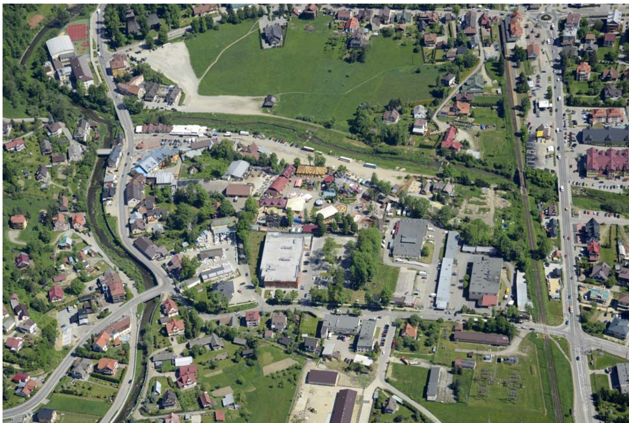
Ryc. 3. Widok fragmentu układu ruralistycznego Rabki z terenem dawnego dworu. Fot. W. Gorgolewski, 2017
