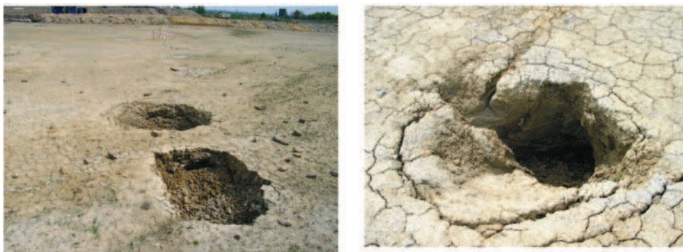
Rys. 7. Widok na powstałe leje po ulewnych deszczach na terenie MOP-u Halemba w części południowej [3]
