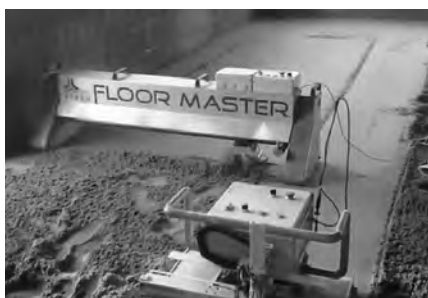
Rys. 5. Równiarka posadzkowa Floor-Master podczas pracy [15]
