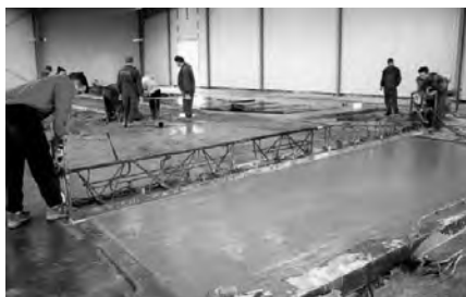
Rys. 4. Przykłady stosowania listw wibracyjnych – pneumatycznej i pływającej [14]
