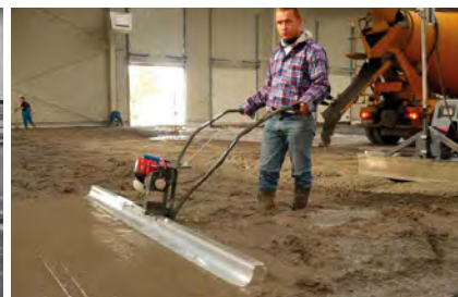
Rys. 4. Przykłady stosowania listw wibracyjnych – pneumatycznej i pływającej [14]
