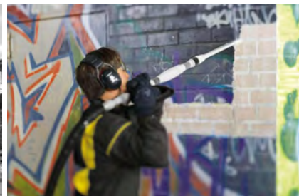
Rys. 3. Czyszczenie muru przy użyciu suchego lodu [13]
