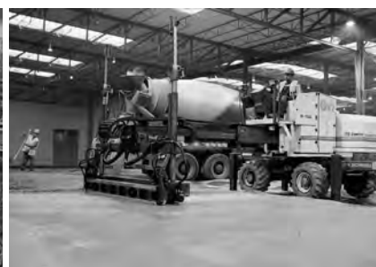
Rys. 6. Wykonywanie posadzki betonowej kombajnem Somero Laser Screed S-160 [16]
