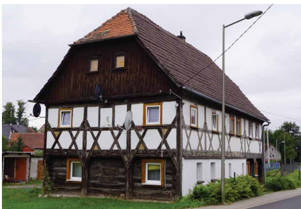
Il. 5. Budynek piętrowy z konstrukcją przysłupową z dachem opartym na ścianie ryglowej (fot. A. Chądzyński)
