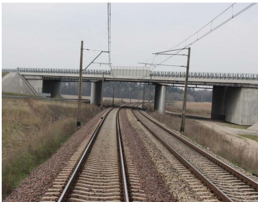
Line No. 353, section Inowrocław – Więclawice
