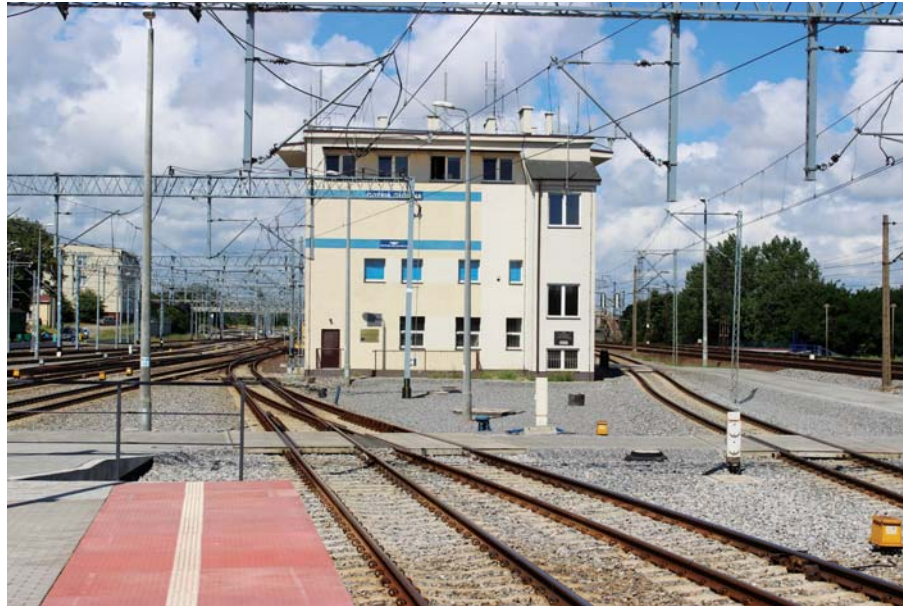
Line No. E65, modernized station Gdynia Główna
