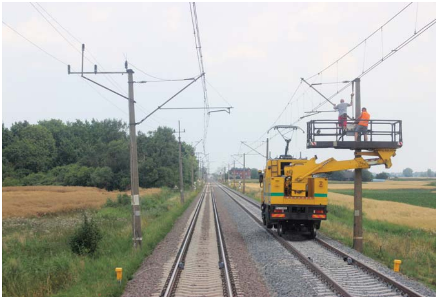
Line No. 353, section Inowrocław – Więclawice
