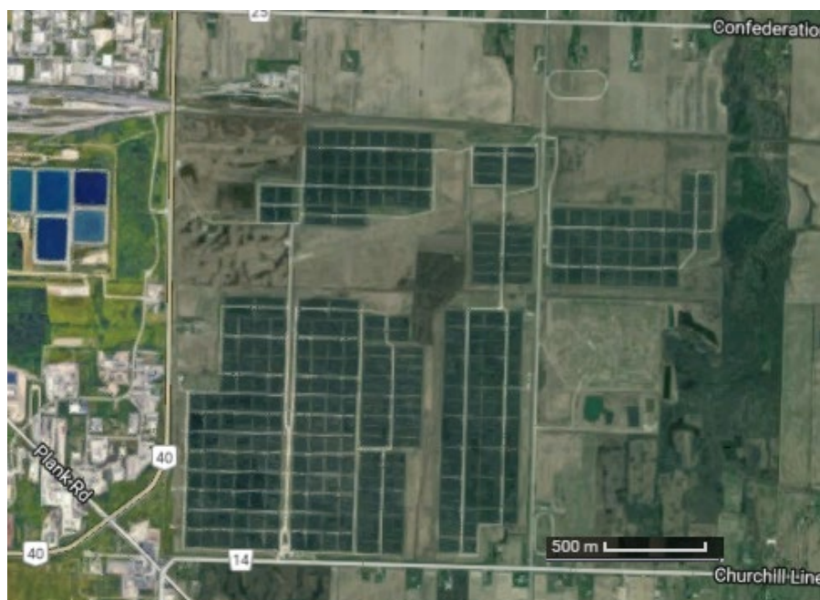
Ryc. 1. Elektrownia fotowoltaiczna w Sarnii widoczna na www.maps.google.com, stan na 10.01.2017
