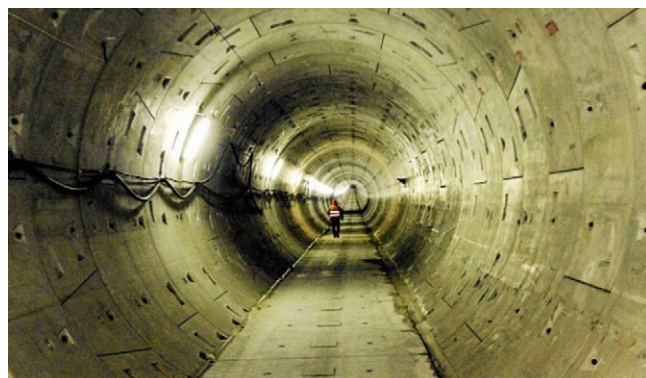
Rys. 1. Tunel prowadzący ścieki do Oczyszczalni Czajka pod dnem Wisły
