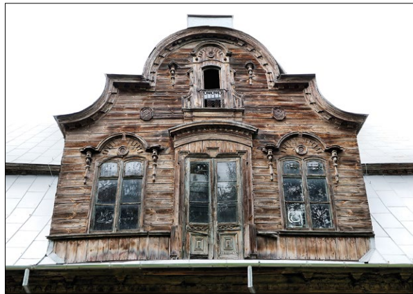
Ryc. 2. Elewacja facjaty wschodniej; fot. M. Warchoń 2020.
