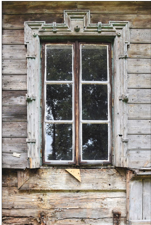
Ryc. 4. Okno w elewacji wschodniej z odkrywką pierwotnego oboknia; fot. E. Zawaleń 2020.
