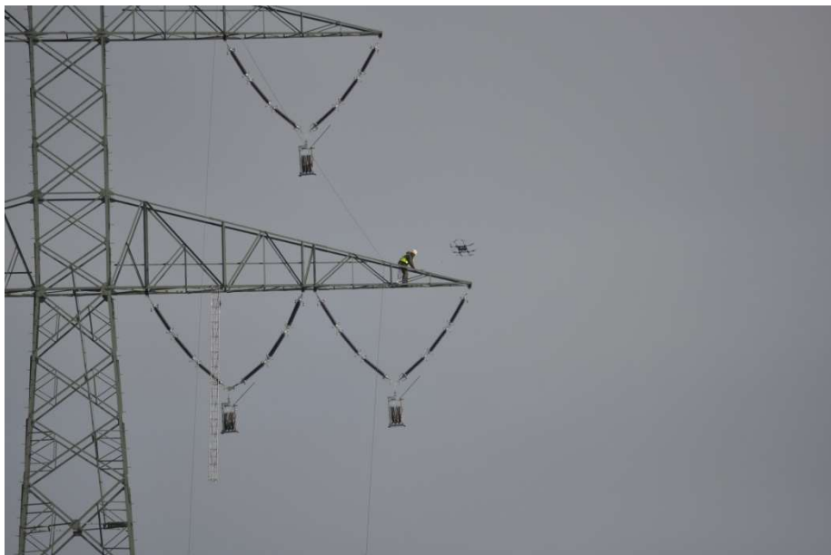
Rys. 5.3 Przeciąganie linki przedwstępnej przez BSP
