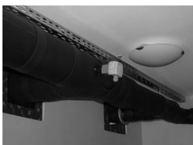
Rys. 6. Fragment instalacji znajdującej się w osłonie termicznej budynku.
