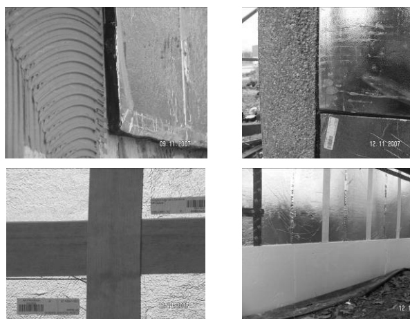
Rys. 5. Wykonanie izolacji ściany przy pomocy izolacji próżniowej – ściana C.
