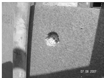
Rys. 3. Punktowy montaż płyt styropianowych – ściana B.
