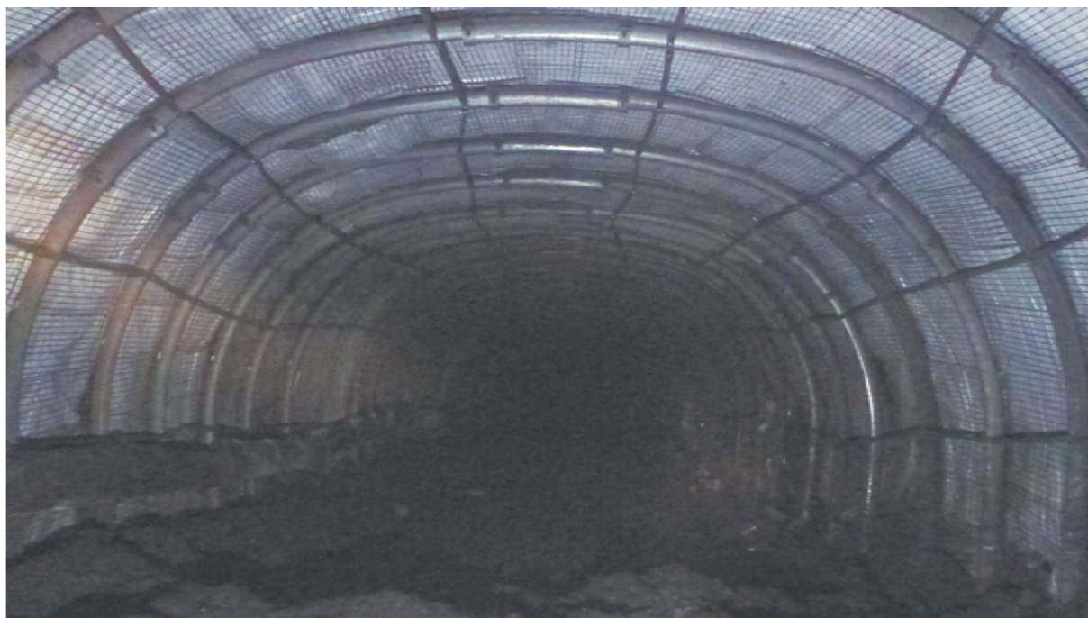
Rys. 6. Ogólny widok obudowy Chodnika wodnego B1/7 (obudowa w wersji lekkiej)
