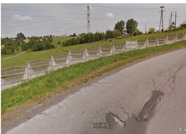
Rys. 4a. Ogólny widok terenu (odkształcenia i uszkodzenia nawierzchni drogowej)
