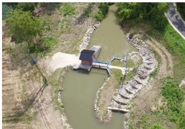
Rys. 7. MEW wyposażona w śrubę Archimedesą pracująca falownikiem ABB serii ACS880 w jednej z elektrowni wodnych w Polsce
