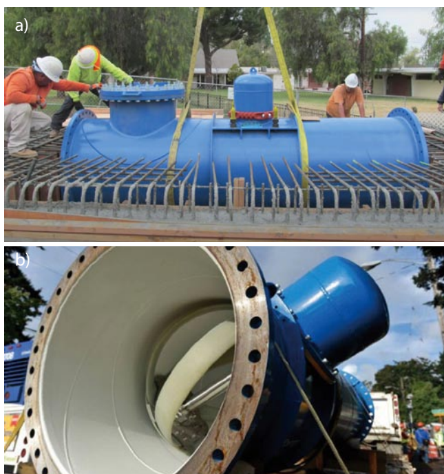
Rys. 10. Turbina energetyczna instalowana na sieci wodociągowej (źródło: Zakład Produkcji Wody „Pomorzan” w Szczecinie)
