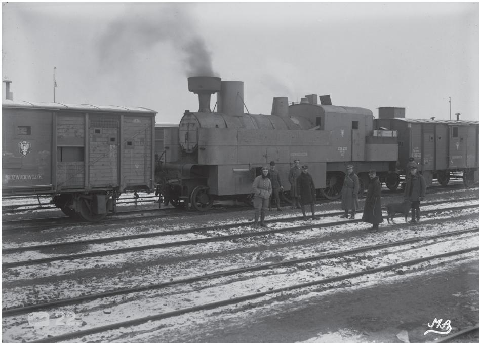
Fot. 8. Pociąg pancerny L.5 (PP 8) „Rozwadowczyk”, z parowozem nr 229.230 „Nowy Sącz IX” opancerzonym w Warsztatach Głównych w Nowym Sączu, na stacji w Nowym Sączu
