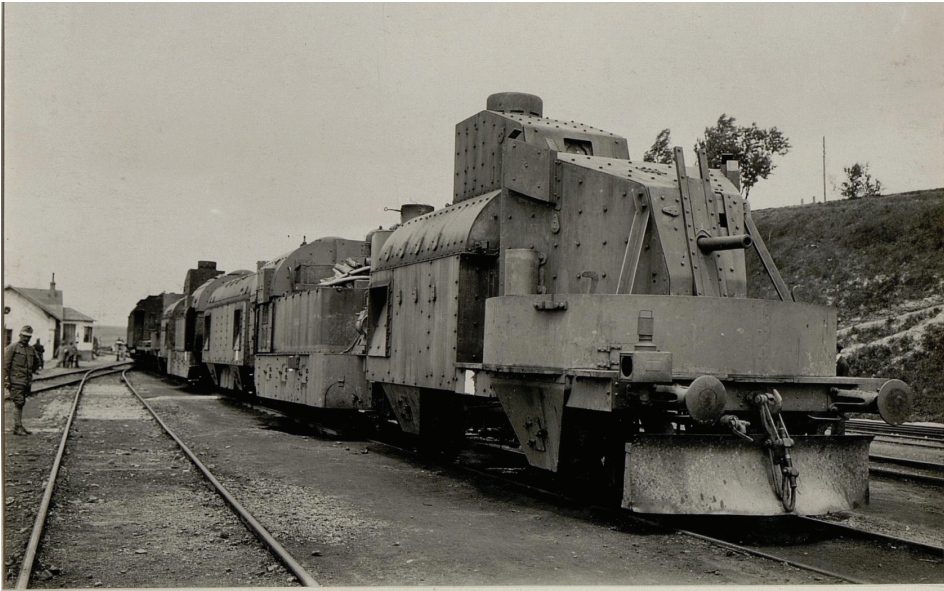
Fot. 2. Pociąg pancerny PZ VIII (typu B) K. u. k. Staatsbahnen na stacji Zborów. Na czele składu wagon artyleryjski nr 140.164, za nim parowóz pancerny 377.131, wagon karabinów maszynowych S 150.052, drugi parowóz 377.117 i wagon artyleryjski 141.455.
