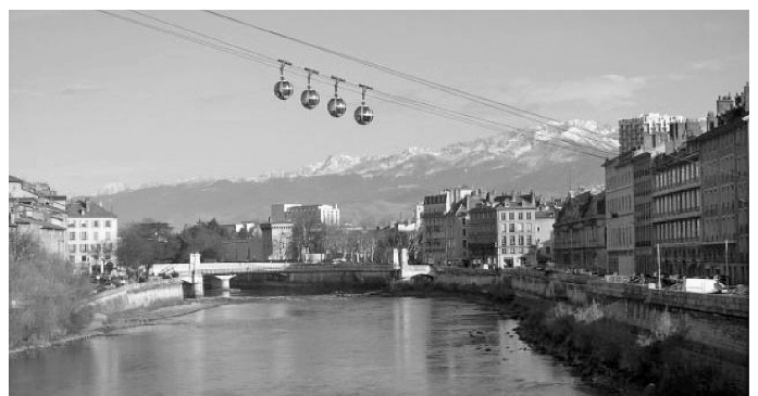
Fot. 5. Napowietrzna kolej dwulinowa z grupowym zawieszeniem pojazdów w Grenoble
