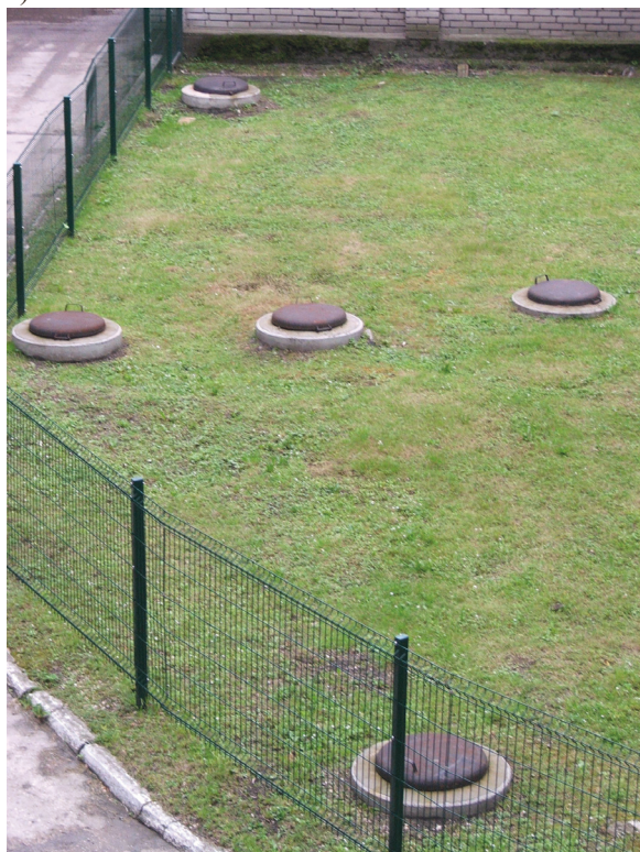
Rys. 3. Studzienki rewizyjne pięciu otworowych wymienników ciepła (a); studzienki z kolektorami słonecznymi do produkcji ciepła do magazynowania w górotworze (b) [60]
