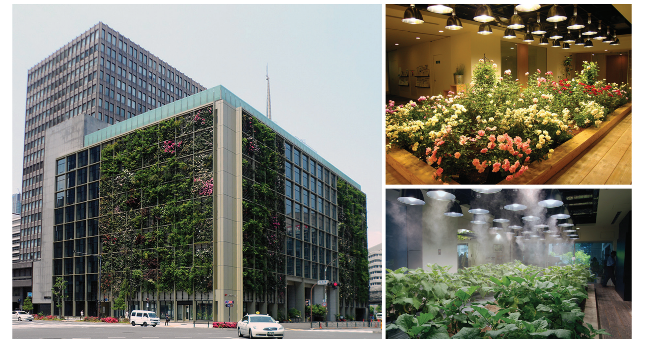
il. 3. Budynek i wnętrza miejskiej farmy pionowej, siedziby korporacji rekrutacyjnej w Tokio. Źródło: https://upload.wikimedia.org/ , https://cdn0.vox-cdn.com/uploads/ , https://kristaninijapan.files.wordpress.com/ , dostęp 02-03-2017 / The building and interior of the urban vertical farm, the headquarters of the recruiting corporation in Tokyo. Source: https://upload.wikimedia.org/ , https://cdn0.vox-cdn.com/uploads/ , https://kristaninijapan.files.wordpress.com/ , access 02-03-2017
