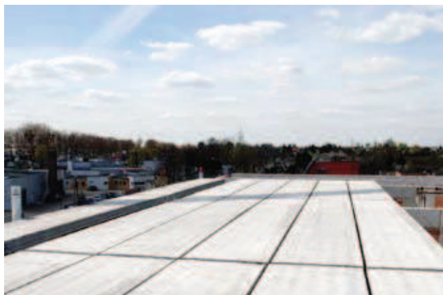
Rys. 2. Strop wykonany z kanałowych płyt strunobetonowych (źródło: www.stropy.pl , dostęp z dn. 29.08.2016)
