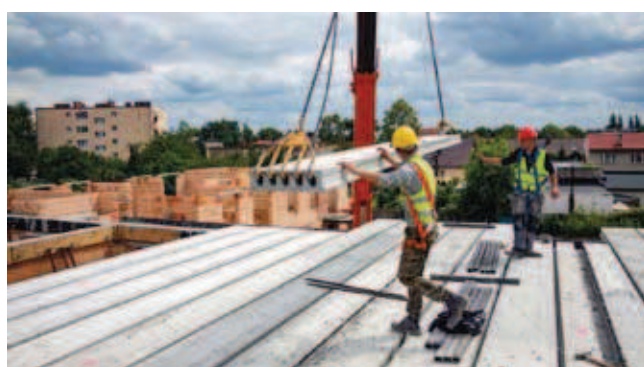
Rys. 5. Lekki strop panelowy Smart „na budowie” (źródło: Archiwum firmy Fabryka Stropów)
