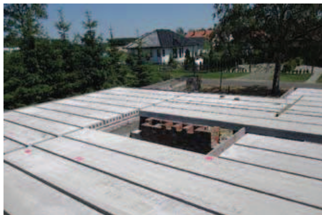
Rys. 4. Lekki strop panelowy Smart „na budowie” (źródło: archiwum firmy Fabryka Stropów)
