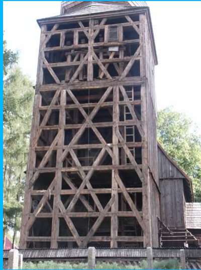
Rys. 4. Widok wieży z odsłoniętą konstrukcją
