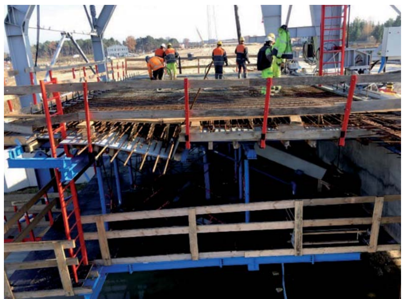
Fot. 2. Prace na urządzeniu MSS
