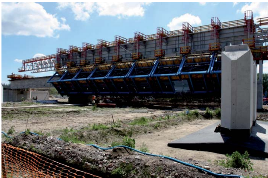
Fot. 3. Metoda podłużnego nasuwania
