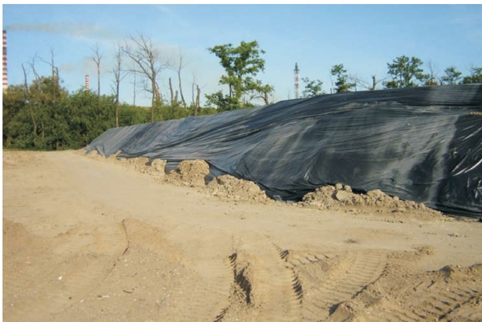
Rys. 17. Pryzma po przykryciu folią [12]
