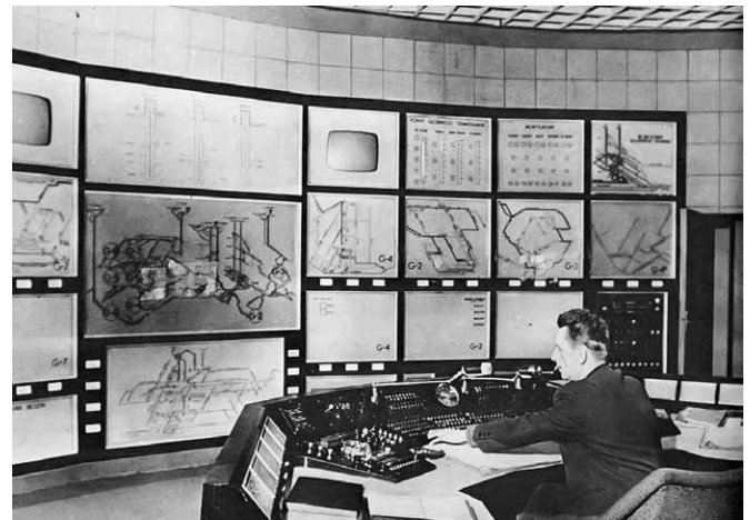
Dyspozytornia KWK „Paryż” w Dąbrowie Górniczej (lata 1967–1972)
