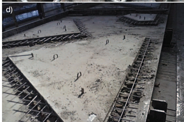
a) Wykonanie obrzeży form na stołach, a następnie wyścielenie szalunku papierem; b) Przyklejenie cegieł/skały wulkanicznej do papieru; c) Ułożenie siatki zbrojeniowej oraz akcesoriów do mocowania; d) Wygląd elementów po zabetonowaniu
