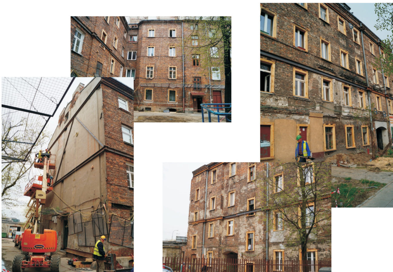
Fot. 1. Zabezpieczanie budynków nad budowaną linią metra
