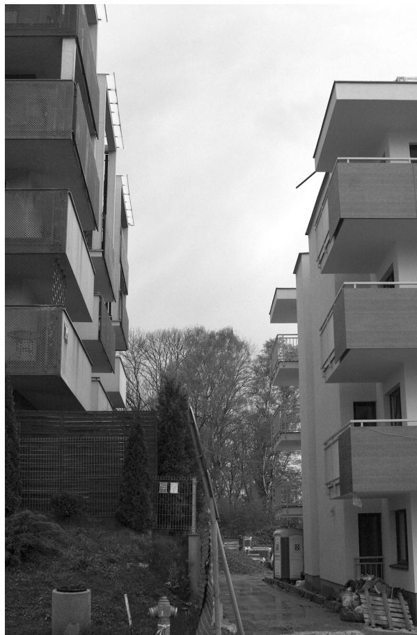
il. 4. Dzielnica Dębniki, Kraków. Odległość między budynkami 9,6 m (bez uwzględnienia balkonów). (autor: Karolina Warzocha) / District Dębniki, Cracow. A distance between buildings is 9,6 m (without balconies) (author: Karolina Warzocha)
