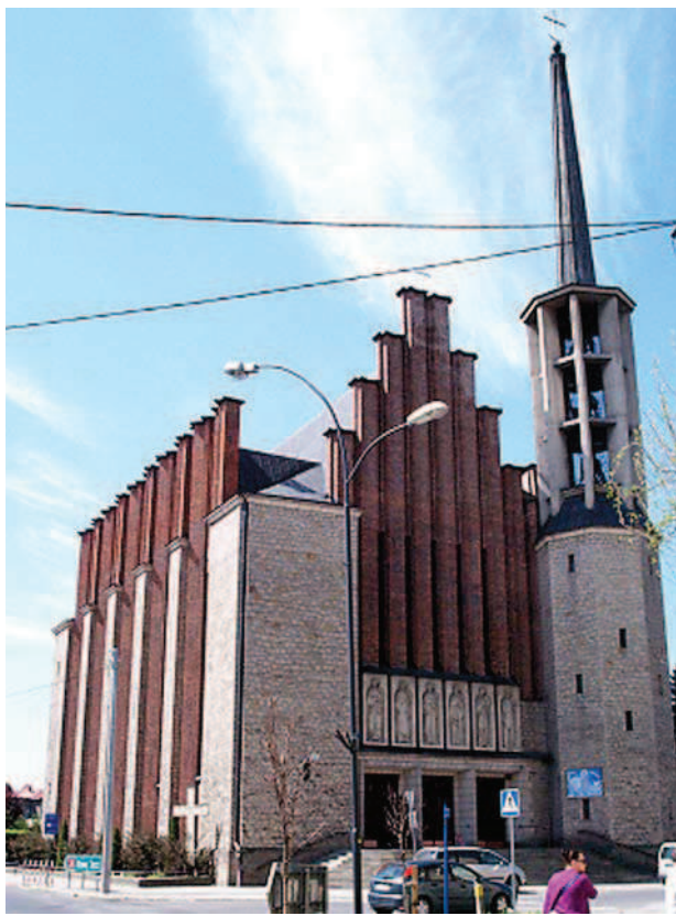
Ryc. 1. Fasada kościoła oo. Franciszkanów w Jasle (autor: S. Dudek), 2013 Fig. 1. Facade of the Franciscan church in Jasło (author: S. Dudek), 2013
