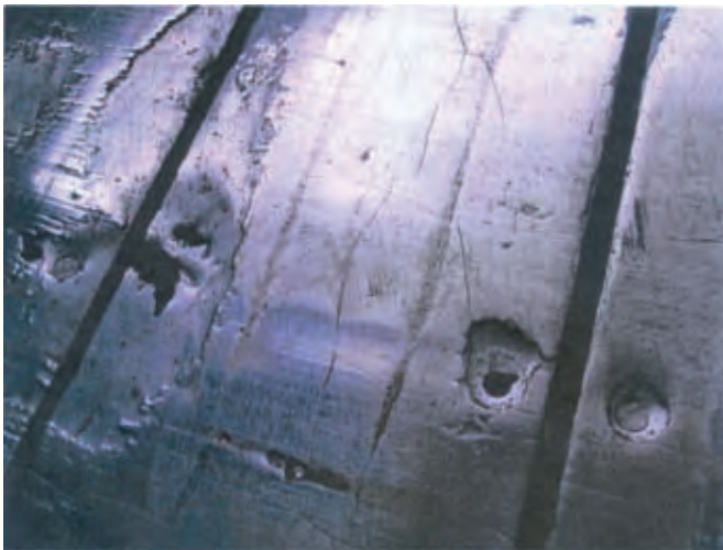
Rys. 2. Koparka SchRs-900. Zużyta wykładzina zsuwni wirującej na skutek obciążeń udarowo-ściernych
