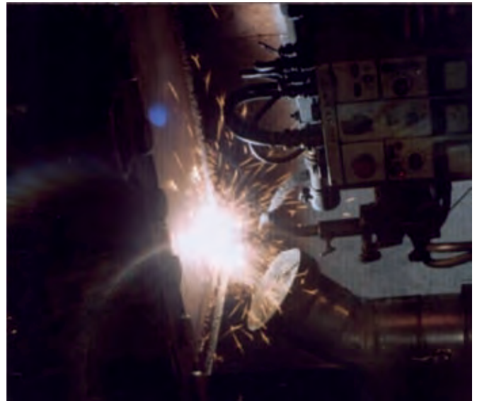
Rys. 4. Dotychczasowe stanowisko do napawania elementów wykładzinowych
