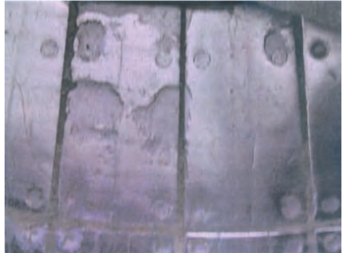
Rys. 3. Koparka SRs-1200. Zużyta wykładzina zsuwni pierścieniowej na skutek obciążeń udarowo-ściernych
